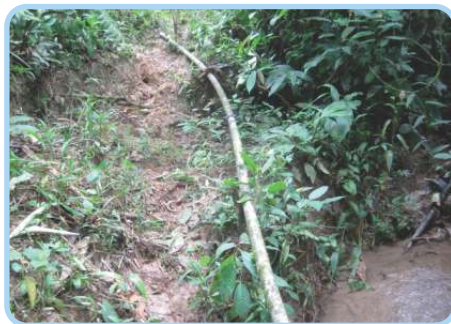
Instalación de tuberías de agua
