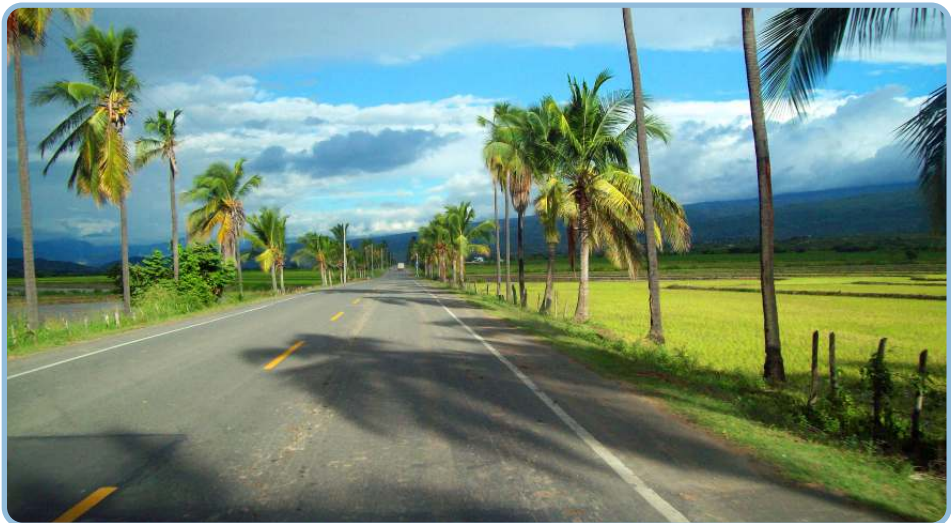
Carretera asfaltada Fernando Belaunde Terri (Bagua)
