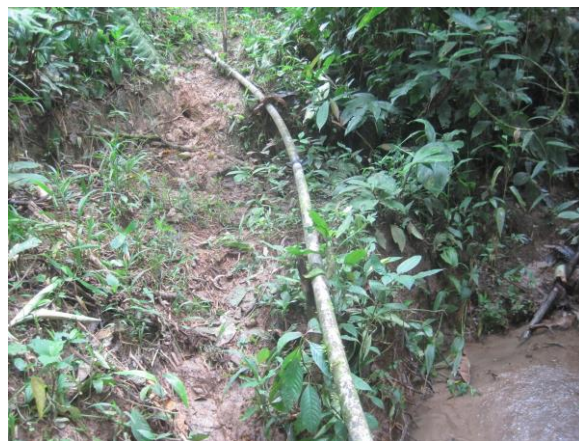
Foto 2. Instalación de tuberías de agua
